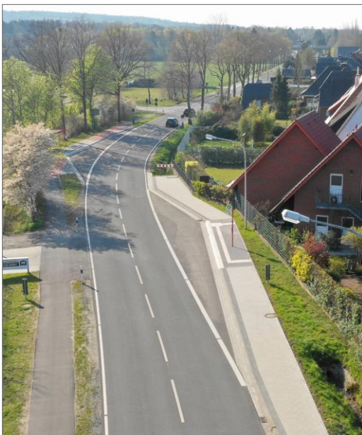
Abbildung 3-22: Haltestelle Bramsche-Hesepe, Bahnübergang B218 als Beispiel für eine Busbucht nach dem Sägezahn-Prinzip (Quelle: eberhard - die ingieure gbr).
