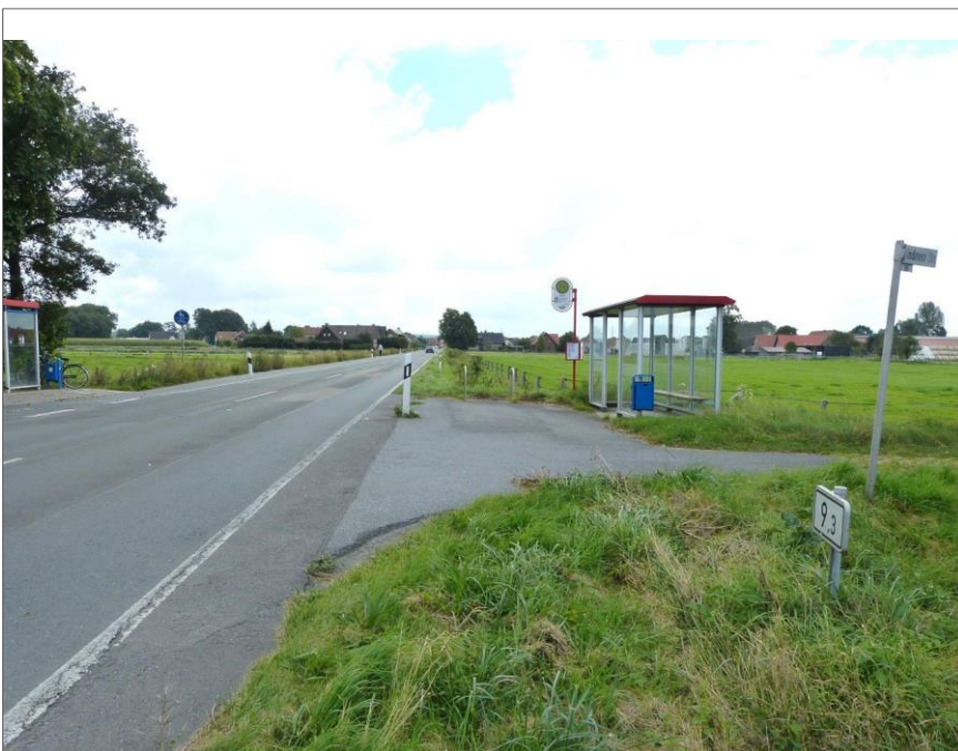
Abbildung 3-20: Haltestelle Jegen West in Bissendorf vor dem Ausbau.
