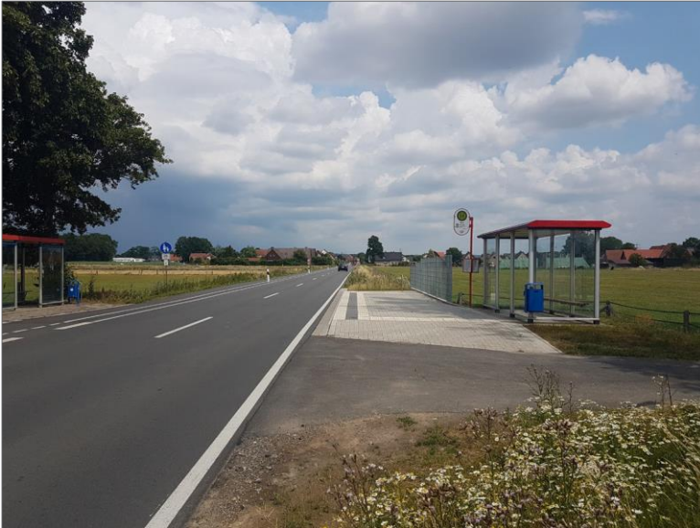
Abbildung 3-21: Haltestellen Jeggan West in Bissendorf nach dem Ausbau als Beispiel für eine Straßenrandhaltestelle.
